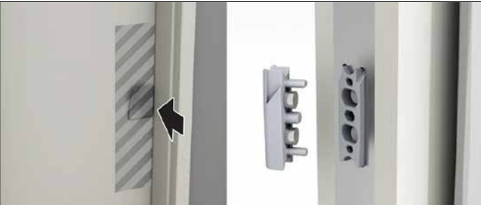
Em caso de emergência, se não puder remover a puxador da porta na parte interna da dobradiça, abra a porta com força, aplicando uma força séria ao redor da área da alça. Com 1 kN de força, o clipe de segurança na trava irá ceder e a porta se abrirá / In the event of emergency, if you cannot remove the door handle on the inside of the hinge, prise open the door, applying serious force around the handle area. With 1 kN of force, the safety clip on the latch will yield and the door will open / En caso de emergencia, si no se eliminó el pudor de una maqueta de una parte de la parte interna, se abrió un porta com força, se aplicó a la red a la red de la zona. Com 1 kN de força, o clipe de segurança na trava irá ceder e porta se abrirá.
